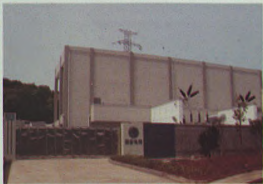
110KV福田变电站
