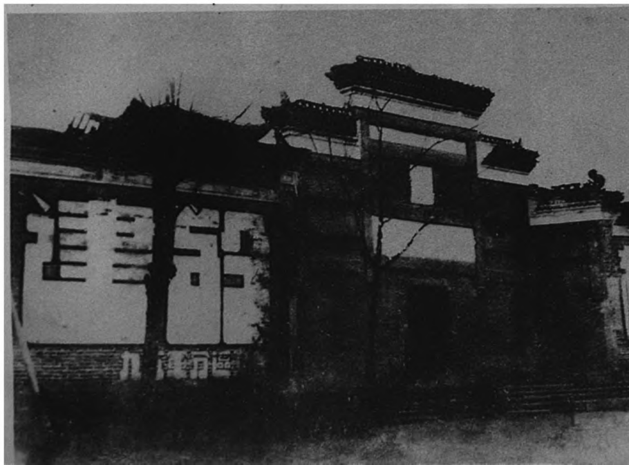
工农革命军第一军第一师第一团团部旧址——修水县凤献书院
