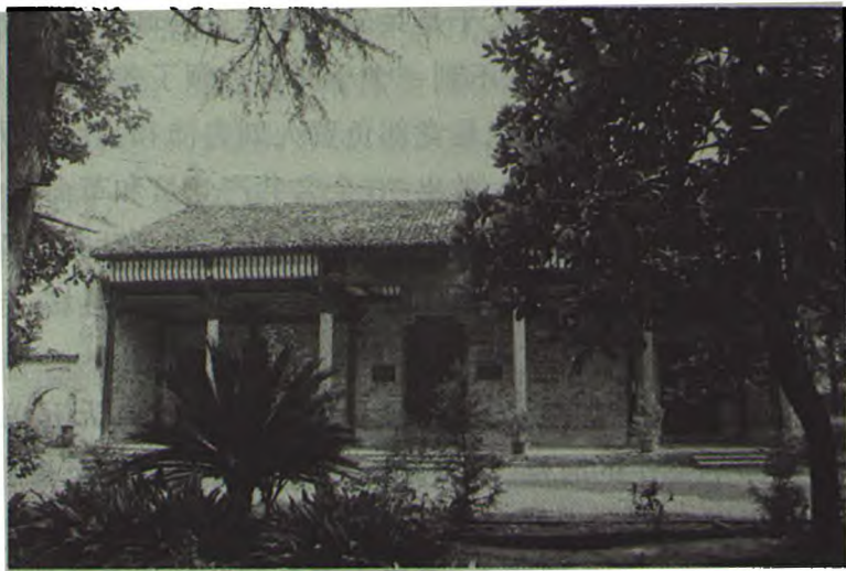
莲花宾兴馆会议旧址
